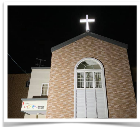
조명 공사 후 밝아진 십자가
